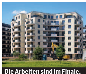
Die Arbeiten sind im Finale.
