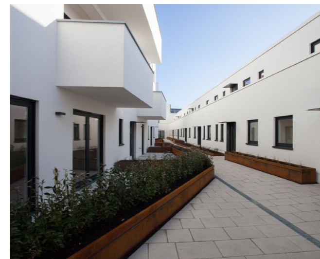
Fig. 8: Magnus 31 © Wilkin & Hanrath Bauphasen
