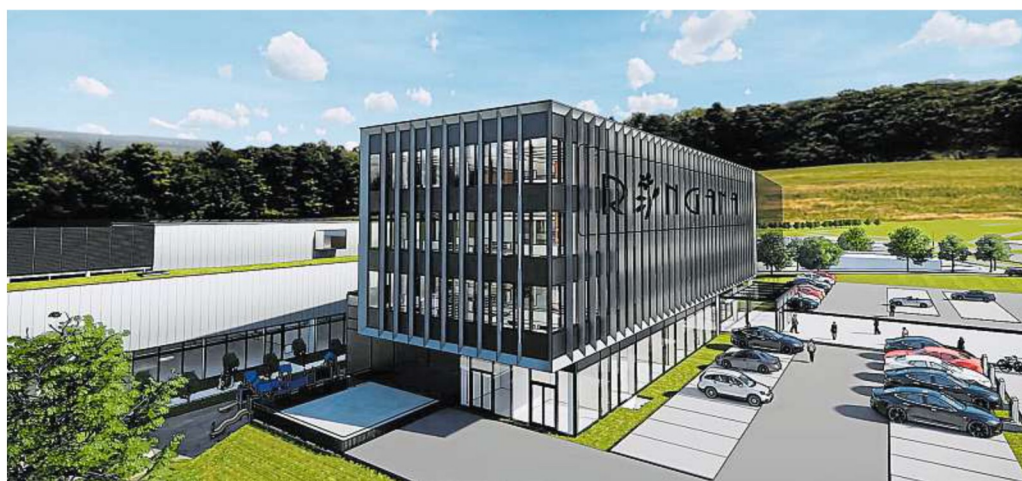
Das neue Produktionsgebäude, das neue Maßstäbe in Sachen Nachhaltigkeit setzt
