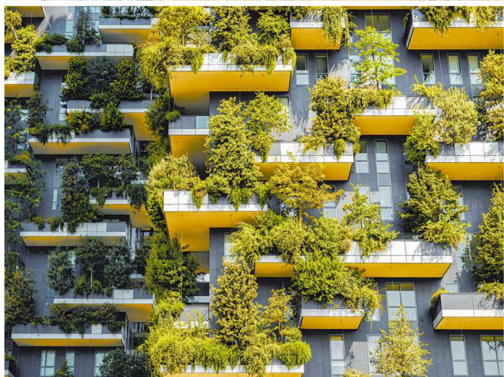
Was bereits möglich ist: Gebäude als Kraftwerke, dezentrale Energieversorgung, Energiequartiere und Sektorkoppelung (Strom, Wärme, Kälte)
