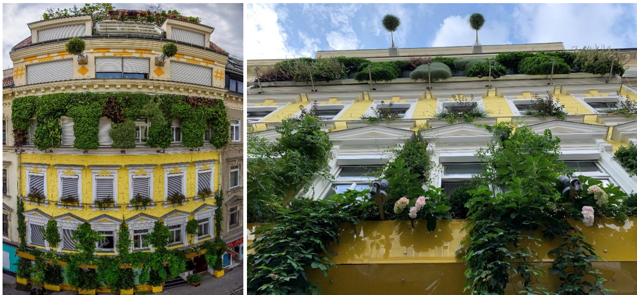
Abbildung 13: Kombination unterschiedlicher Fassadenbegrünungssysteme, Hannovergasse Wien
