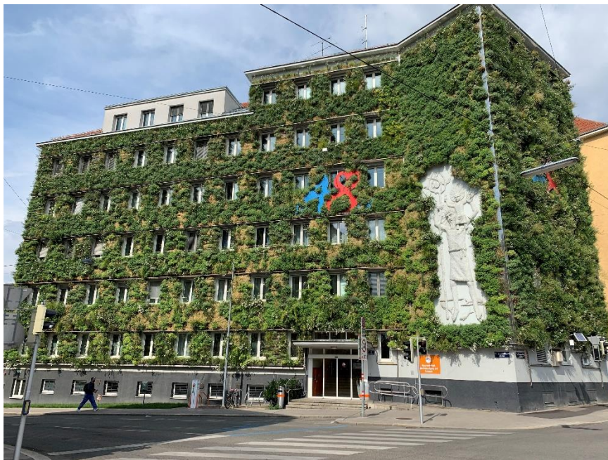
Abbildung 12: Fassadengebundene Vertikalbegrünung, MA 48 Wien, DieStadtbeogrüner
